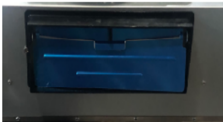
Taper 1 Adaptateur rectangulaire 3 1/4" x 10" derrière la hotte
