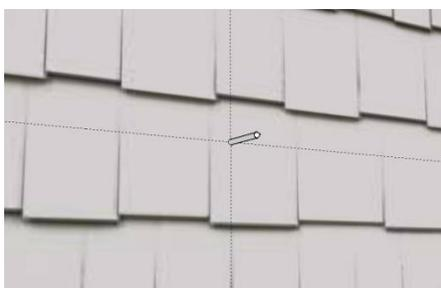
Avec la scie-cloche, en vous guidant sur l'avant-trou, percez un trou de 6 1/4 po.
