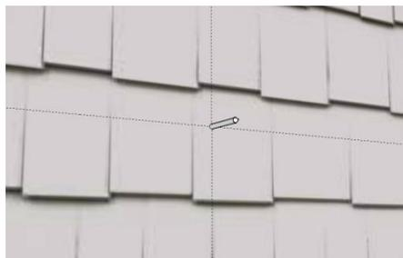
À l'aide d'une scie-cloche, guidez-vous sur l'avant-trou pour percer le trou de 6 $\frac{1}{4}$  po.
