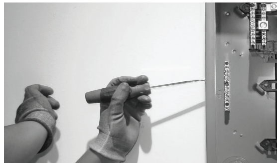
FIG. 1 : Knockout Removal / Extracción de los discos removibles / Retrait de débouchure
